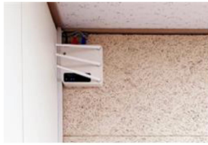
방음벽 설치, 인터넷 공유기 유선 연결
